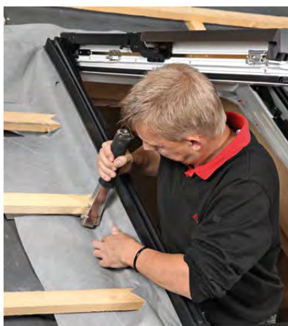
Montaż na łatach montażowych - połączenie wodoszczelne.
