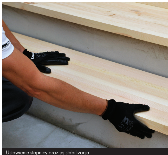
Ustawienie stopnicy oraz jej stabilizacja
