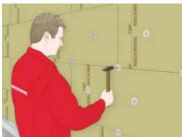
Rozmieszczenie łączników na płytach FASROCK LL
