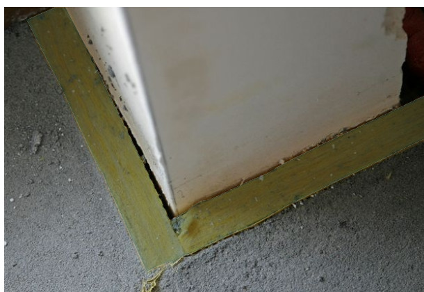
Rys. 3.1.4 Widok pasów dylatacji obwodowej z wełny skalnej STROPOTERM dociętych do powierzchni wylewki.
