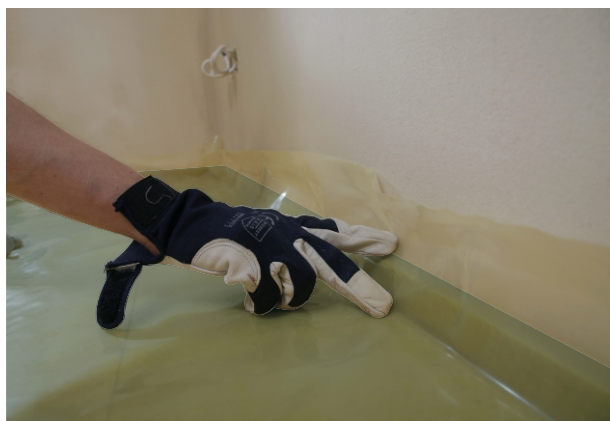
Rys. 3.1.3 Montaż folii paroizolacyjnej STOPAIR na warstwie izolacji z wełny skalnej STROPOTERM.
