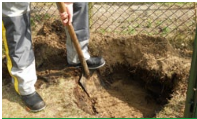
1. Wykopujemy dołek o głębokości 30-40 cm.
