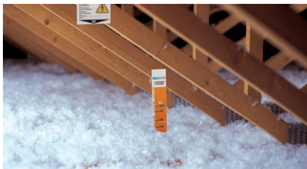
5 Kontrola grubości wdmuchanej izolacji.
