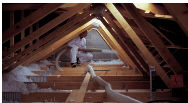
3 Aplikacja wełny na poddasze.
