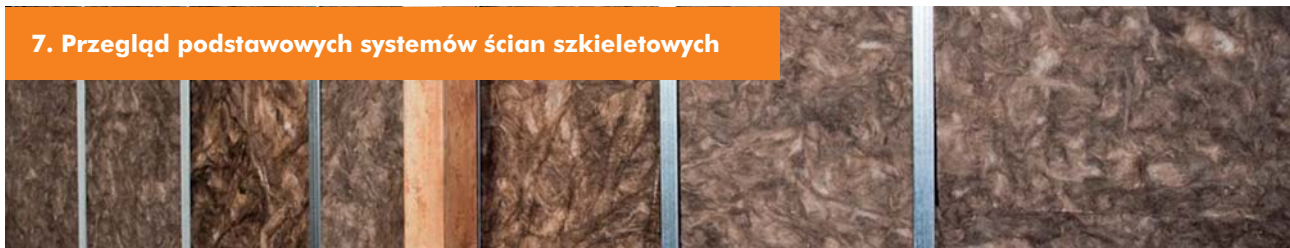
Konstrukcja pojedyncza – okładzina jednowarstwowa SYSTEM W111
